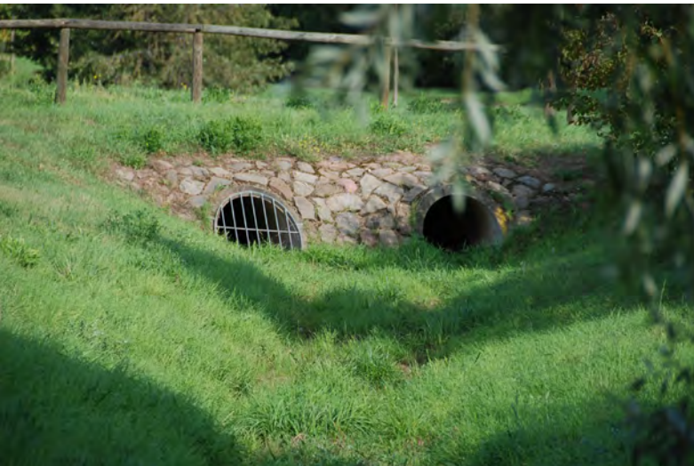
Rigolenentwässerung mit vorgeschalteter Zisterne
