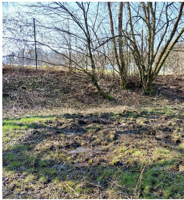
Bild 5: Blick von nördlich des Geltungsbereichs auf den Damm (Hochwasserschutz)
