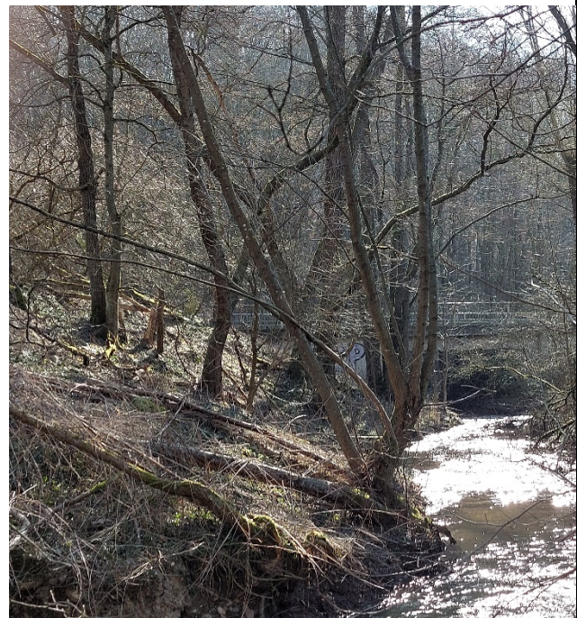
Bild 2: Blick auf das Brückenbauwerk
