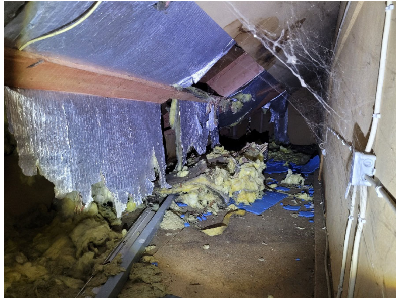
Foto 12: Dachboden des leerstehenden Gebäudes.
