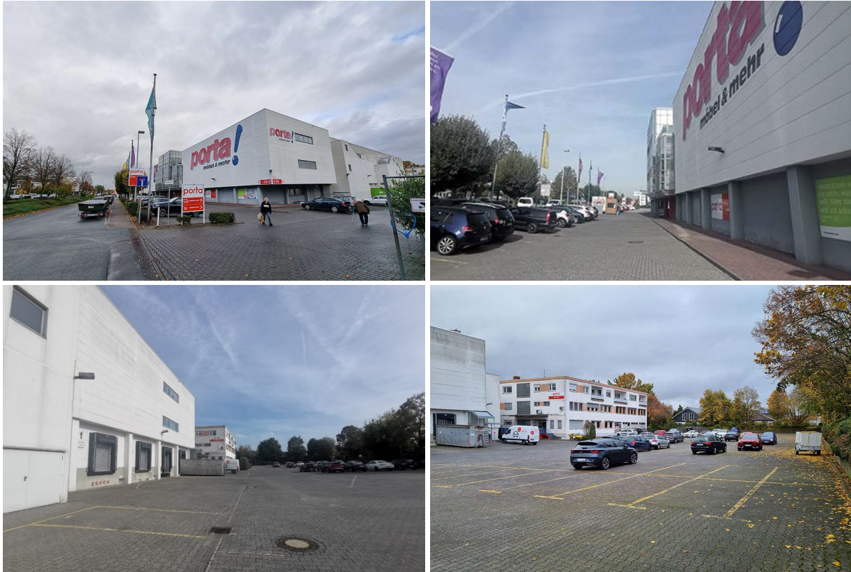
Abbildung 10: Bestehendes Porta Möbelhaus mit Parkplatz, Andienung, Lager und Bürogebäude Quelle: Planergruppe ROB GmbH
