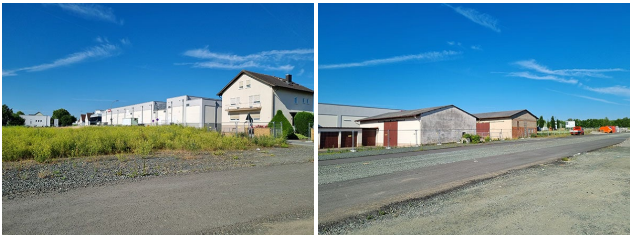
Abbildung 14: Wohngebäude des landwirtschaftlichen Betriebes südlich des Plangebietes mit anschließendem Lebensmittelvollsortimenter (links); zu landwirtschaftlichen Zwecken genutzte Gebäude südlich des Plangebietes (rechts) (Quelle: Planergruppe ROB GmbH, Schwalbach am Taunus)
