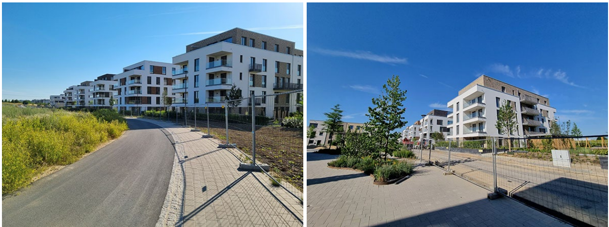
Abbildung 12: Wohnbebauung unmittelbar östlich angrenzend an das Plangebiet (Quelle: Planergruppe ROB GmbH, Schwalbach am Taunus)
