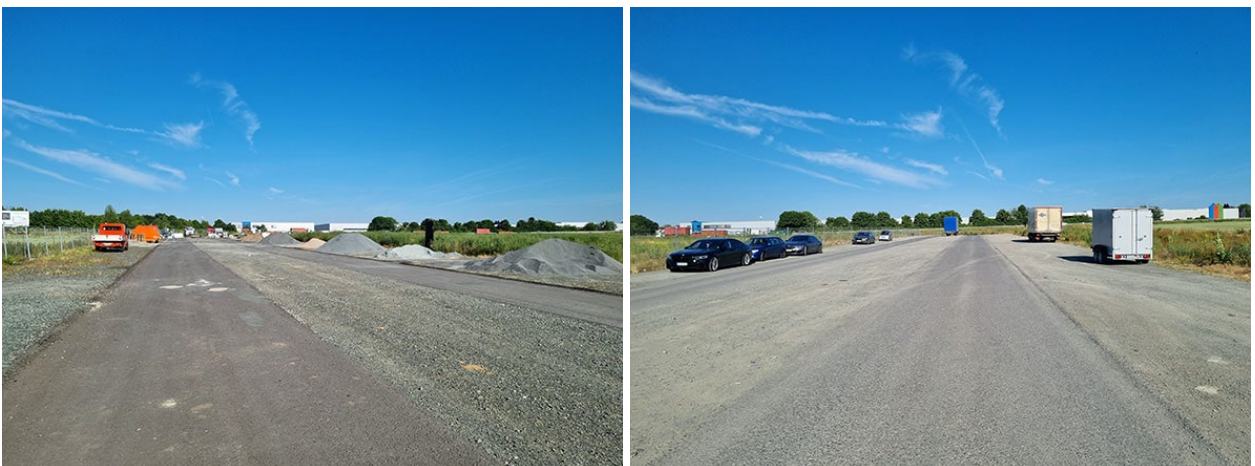
Abbildung 10: Baustraßen innerhalb des Plangebietes (Quelle: Planergruppe ROB GmbH, Schwalbach am Taunus)
