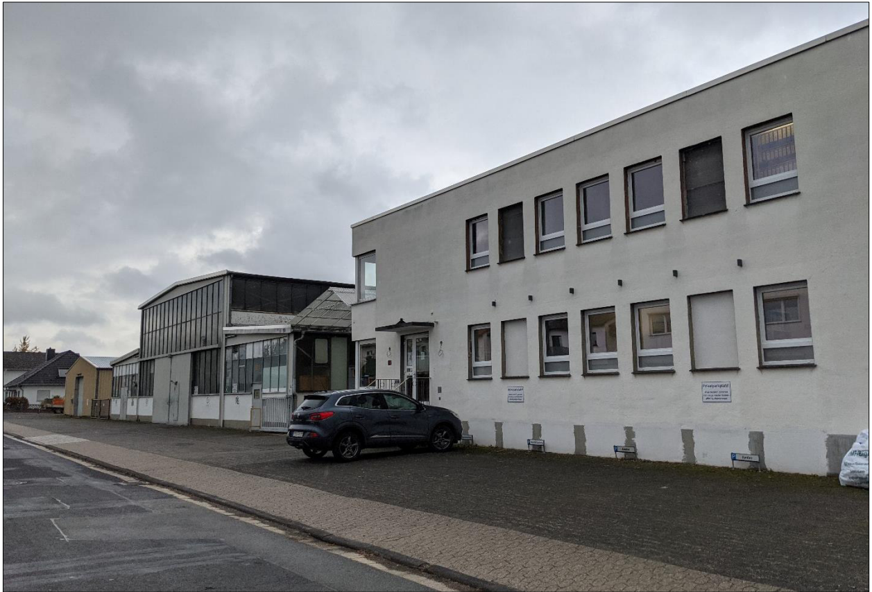
Abb. 4: Blick auf Bestandsgebäude aus nordwestlicher Richtung mit Blick auf den Empfang, Gebäude 3 und Leichtbauhalle (Gebäude 5) im Hintergrund (Foto: IBU, 2.11.2021).
