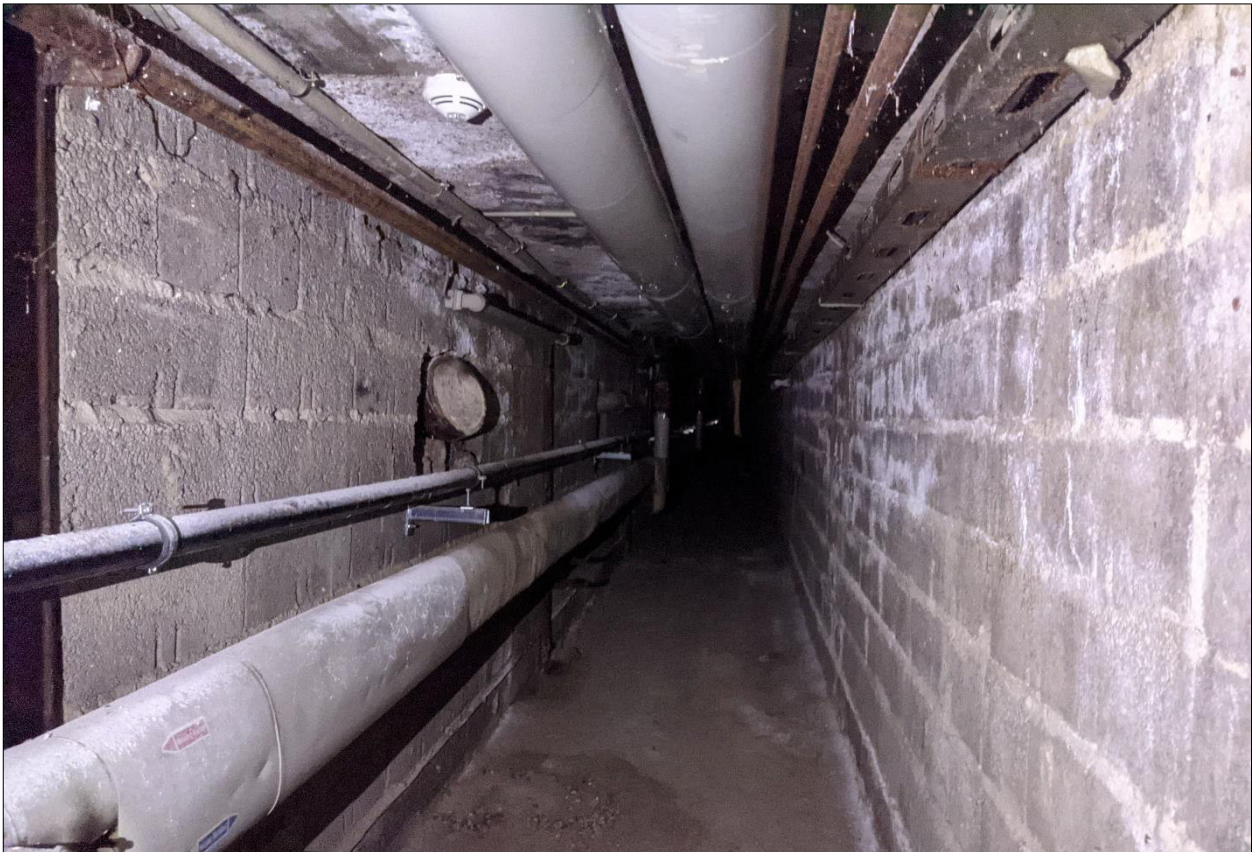
Abb. 7: Versorgungsschacht in den Kellerräumen des Gebäudes 2 (Foto: IBU, 2.11.2021).
