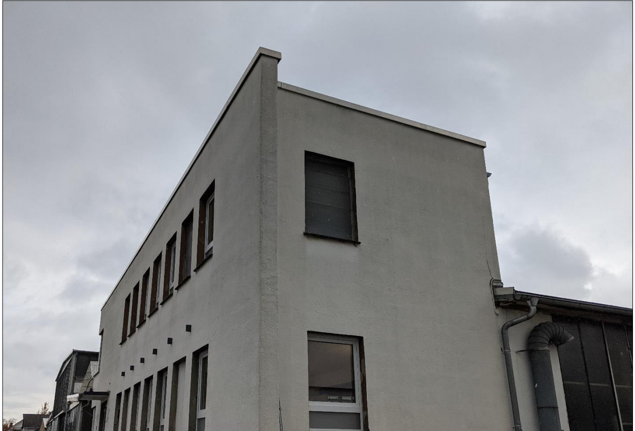
Abb. 23: Dachrandabdeckung auf Gebäude 1, kann bei Lücken in der Abdichtung einen potentiellen Quartierstandort darstellen (Foto: IBU, 2.11.2021).
