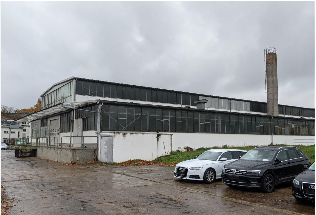
Abb. 10: Blick auf Halle 4 aus Richtung Osten (Foto: IBU, 2.11.2021).
