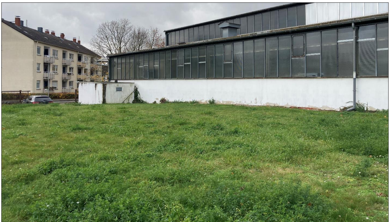
Abb. 18: Grünanlage im Nordosten des Grundstücks (Foto: IBU, 2.11.2021).
