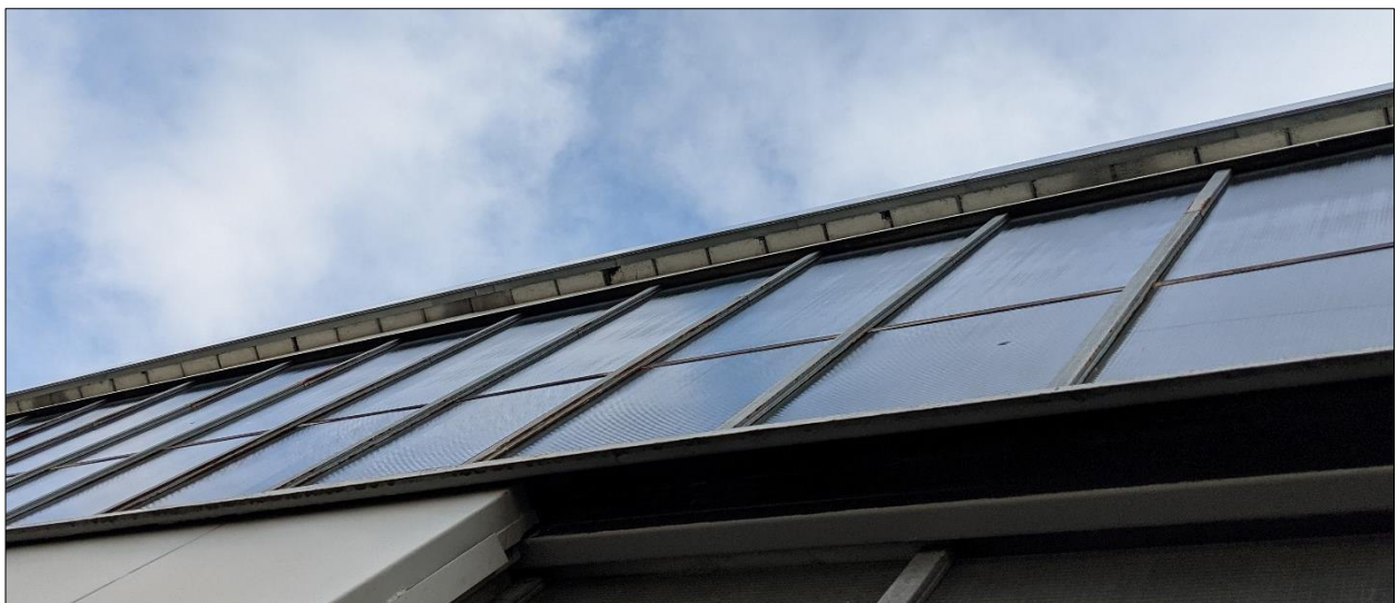
Abb. 22: Spalten in Dachüberstand auf nördlicher Gebäudeseite von Gebäude 3 (Foto: IBU, 2.11.2021).
