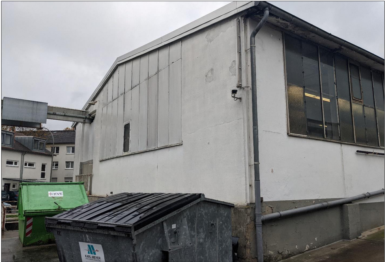
Abb. 8: Südseite des Gebäudes 2 mit Dachüberstand aus Betonplatten und Blechverkleidung (Foto: IBU, 2.11.2021).
