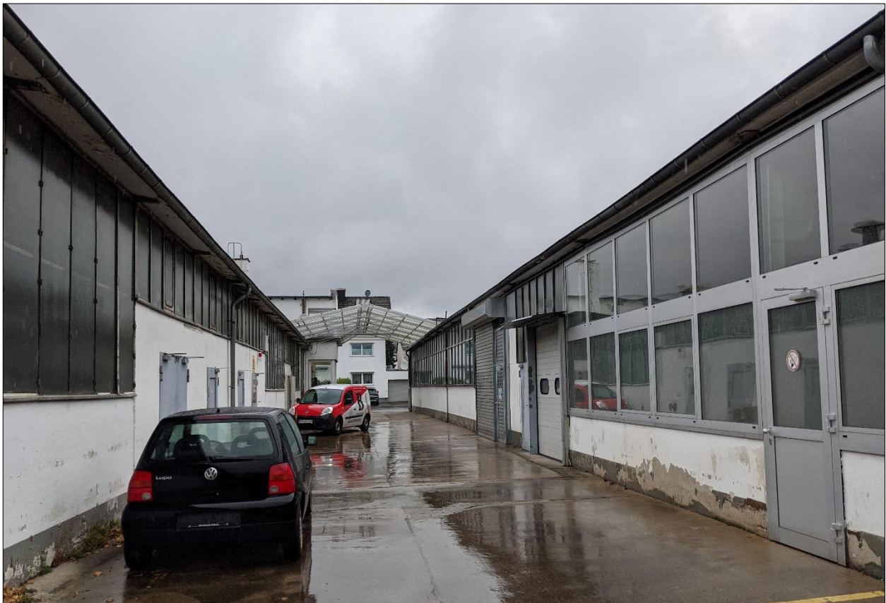
Abb. 9: Durchgang zwischen Gebäude 2 und der Halle 4 und 3 (Foto: IBU, 2.11.2021).
