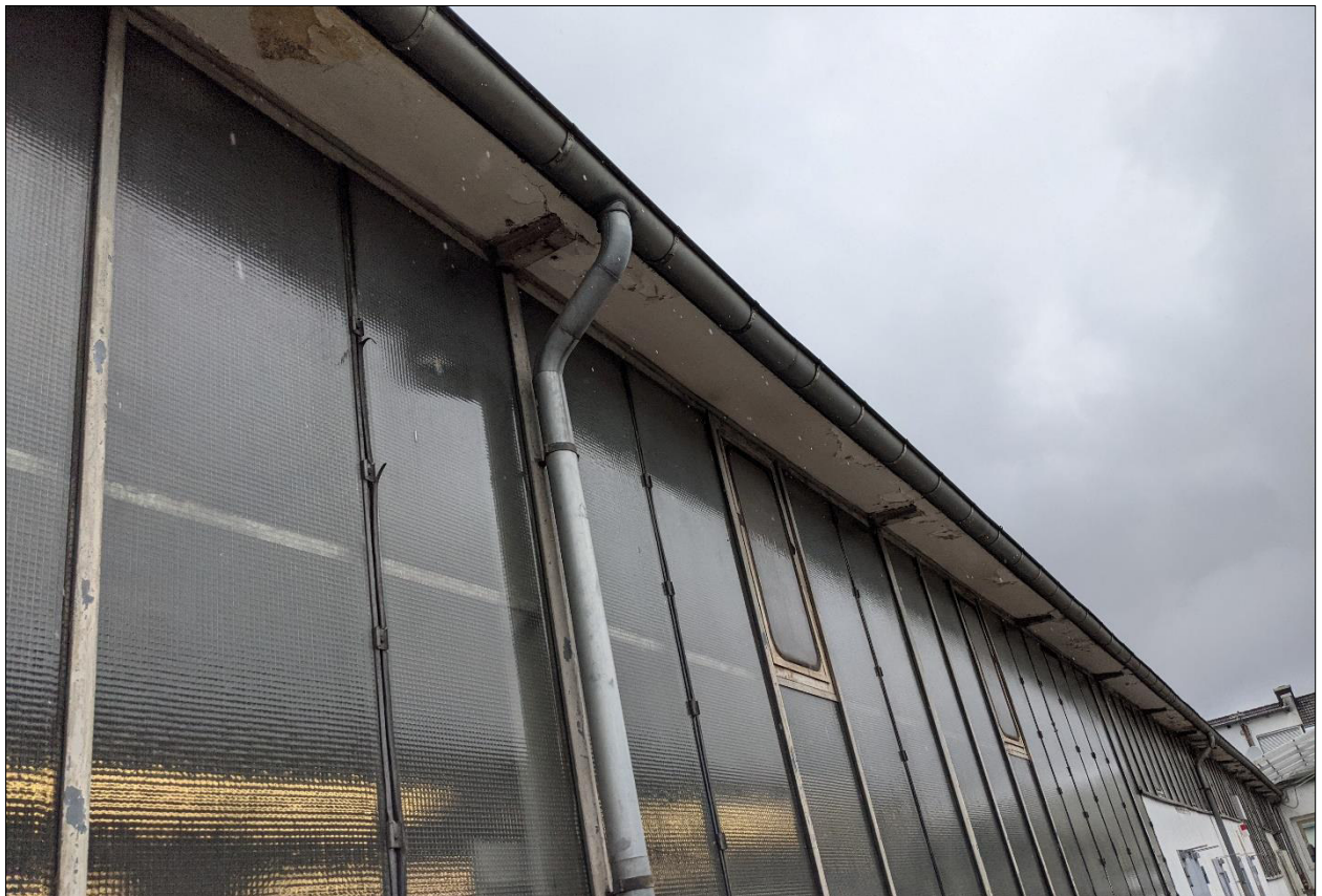
Abb. 24: Dachrandüberstand an Ostseite des Gebäudes 2, der keinerlei Versteckmöglichkeit für Fledermäuse bietet (Foto: IBU, 2.11.2021).
