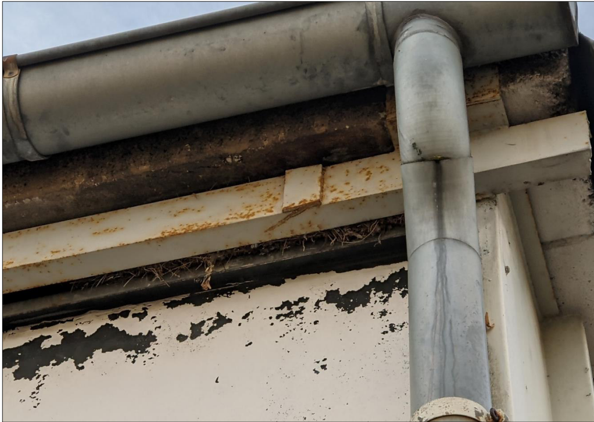
Abb. 25: Sperlingskolonie an der nordöstlichen Hauswand des Gebäudes 3 (vgl. Abb. 2) (Foto: IBU, 2.11.2021).
