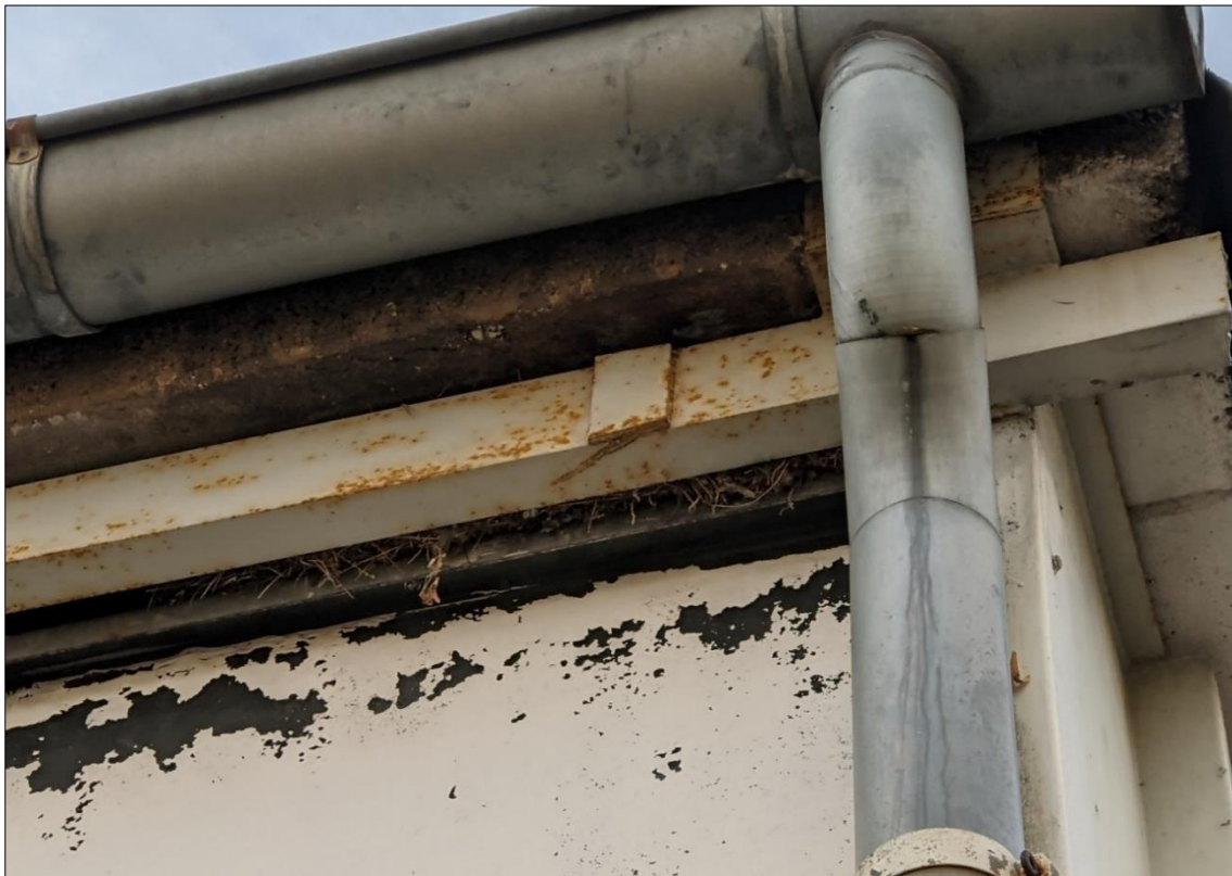
Abbildung 18: Sperlingskolonie an der nordöstlichen Hauswand des Gebäudes 3, Quelle: IBU, 2021.
