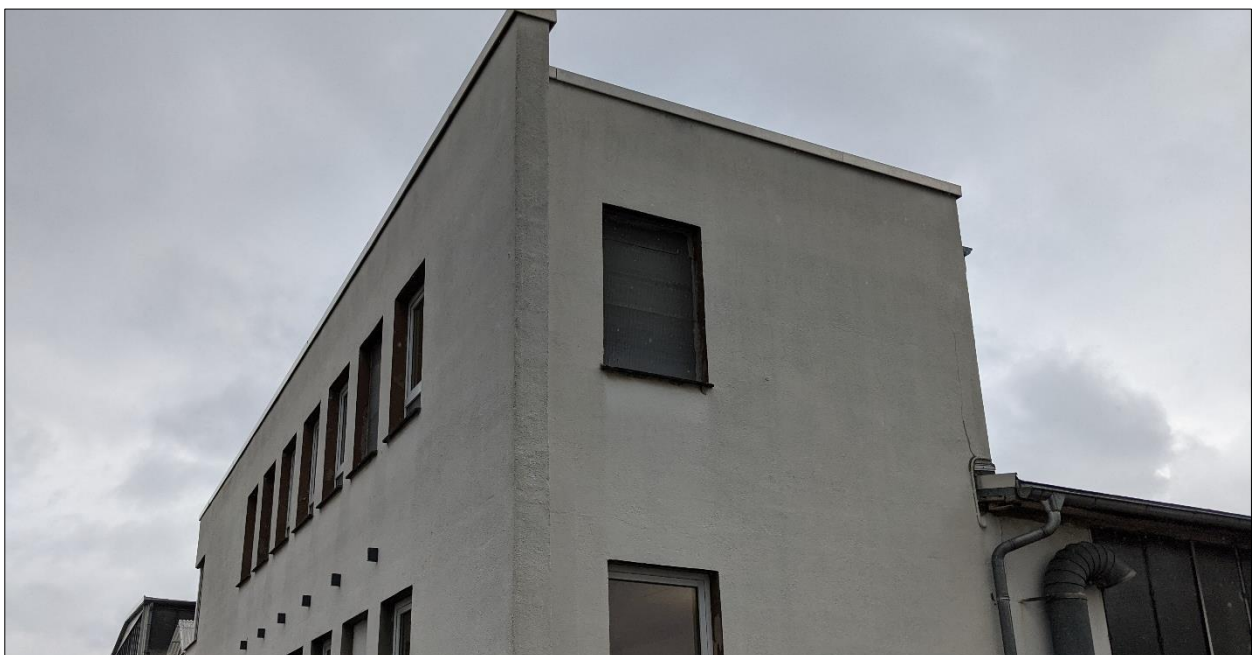
Abbildung 16: Dachrandabdeckung auf Gebäude 1, kann bei Lücken in der Abdichtung einen potentiellen Quartierstandort darstellen. Quelle: IBU, 2021.
