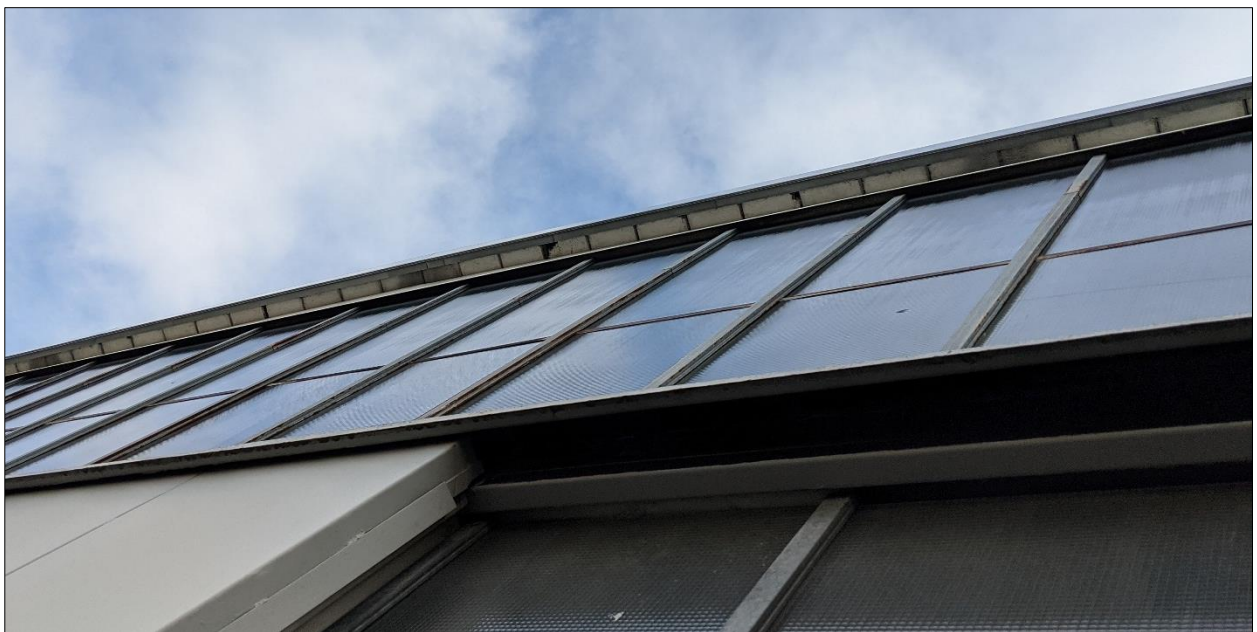
Abbildung 15: Spalten in Dachüberstand auf nördlicher Gebäudeseite von Gebäude 3. Quelle: IBU, 2021.
