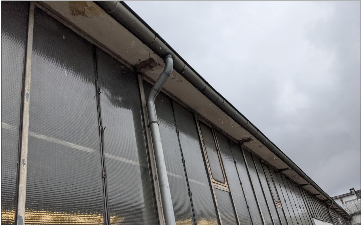
Abbildung 17: Dachrandüberstand an Ostseite des Gebäudes 2, der keinerlei Versteckmöglichkeit für Fledermäuse bietet. Quelle: IBU, 2021.
