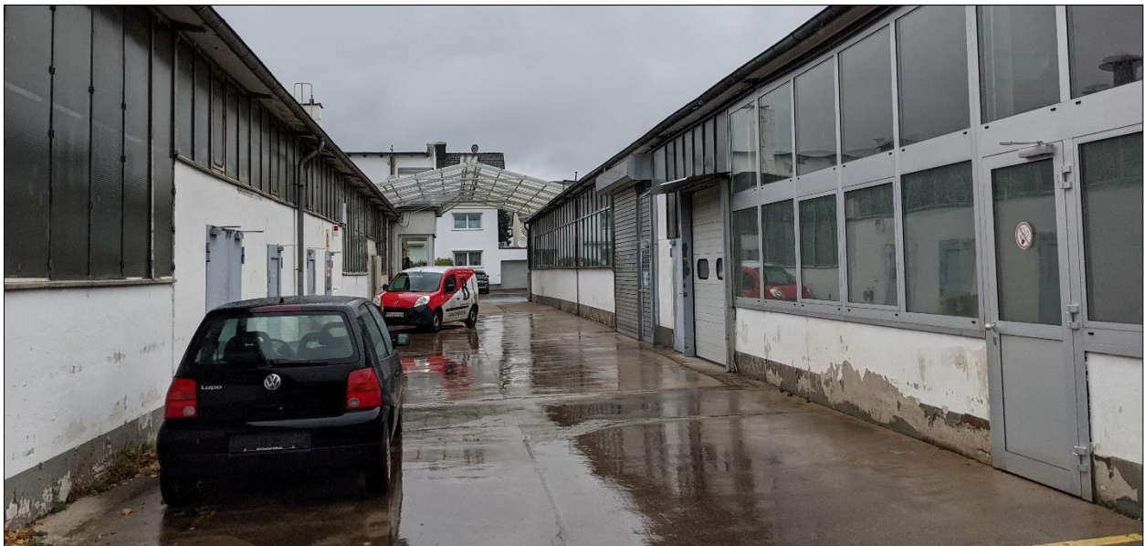
Abbildung 9: Versiegelte Nutzflächen zwischen und angrenzend an den Gebäuden.
