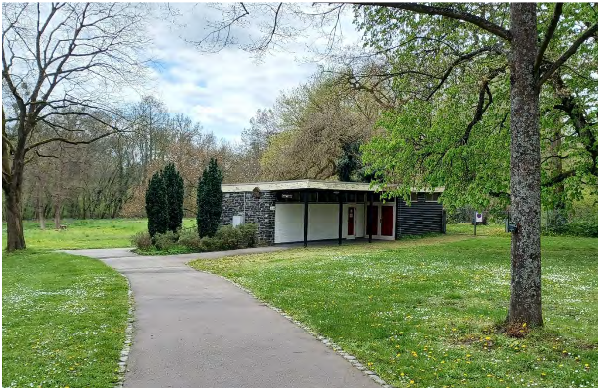
Toilettenanlage im Kurpark im Bestand
