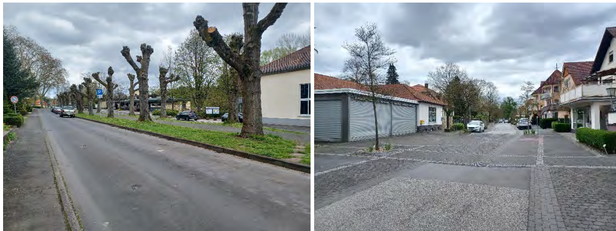
Kurallee (links) und westlicher Bereich der Kurstraße (rechts) im Bestand
