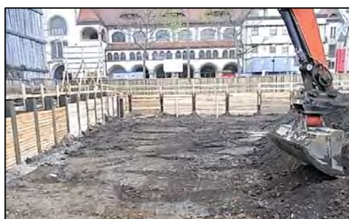
Abb. 4. Schichtenweiser Abtrag, verpflichtend bei baubegleitender KMR
