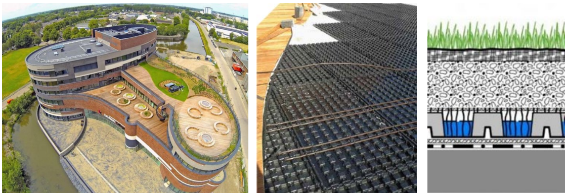
Abbildung 4.6: Aufbau eines multifunktionalen Grün-Blaudaches (Klimadach) 8
