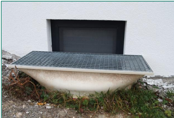
Abbildung 57: Beispiel für Überflutungsschutz: Kellerfenster mit erhöhtem Lichtschacht (Quelle: LUBW)
