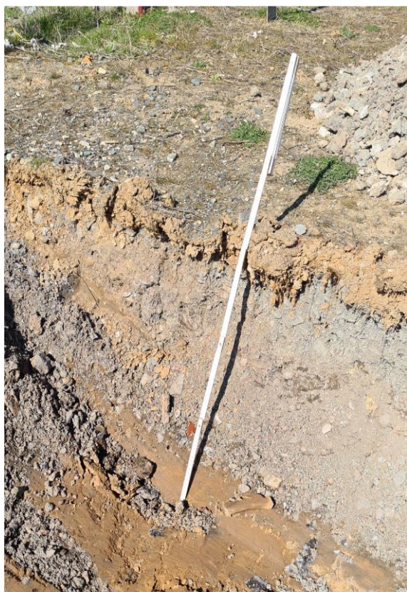
Oberflächenabtrag bis zu 40cm
