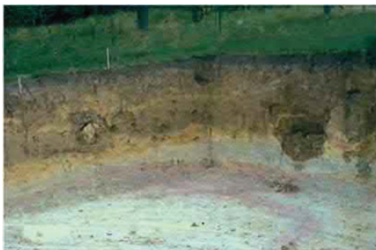
Bild 2: sog. Brandungsblöcke in einer Baugrubenwand, Bild aus [9], rechts Hohlform, Geröll/Block entfernt, links kleiner Block
