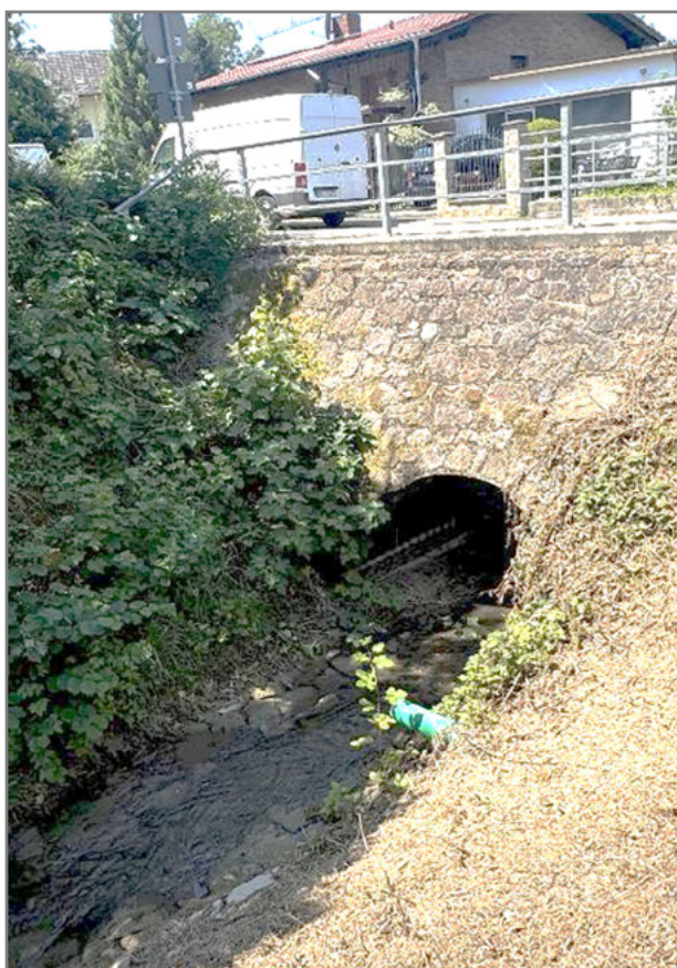
Abbildung 3: Einleitung in den Welzbach
