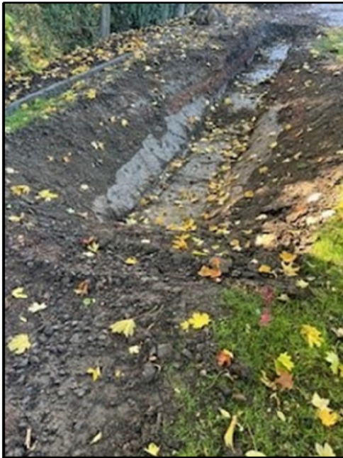
Abbildung 11: Hergestellte Versickerungsfläche, Oktober 2025 siehe Lagepläne
