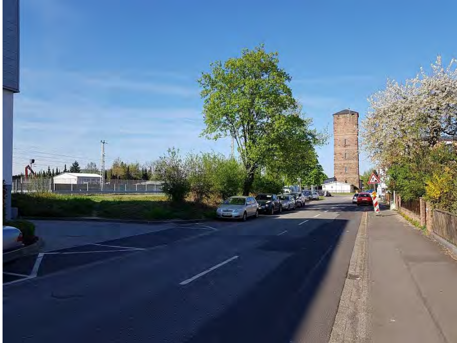
Abb. 1: Blick entlang der Hailerer Straße Richtung Westen auf Teilbereich 3, ehem. Shell-Tanklager (Foto BFU GmbH, 18.04.2018)
