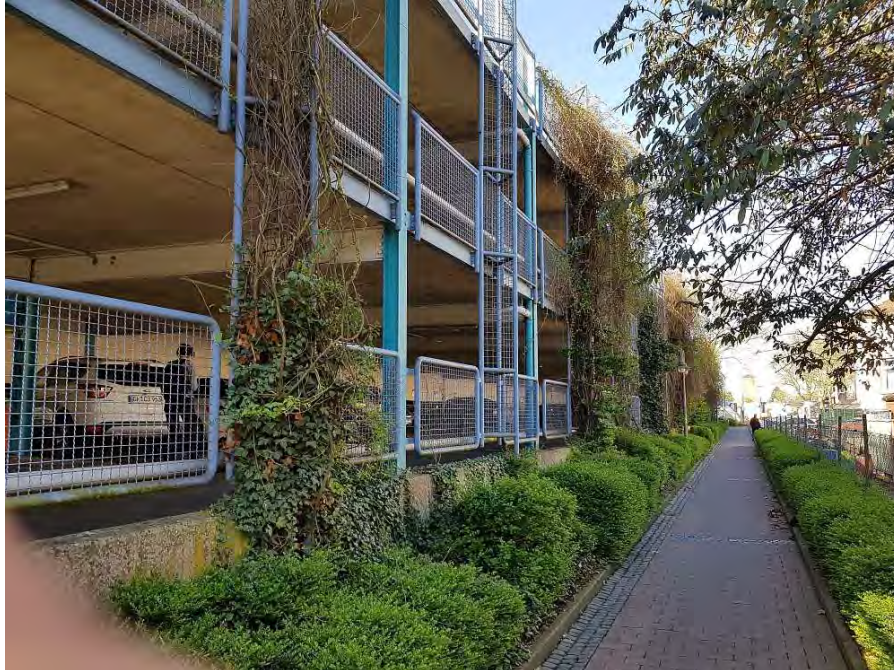
Abb. 11: Blick Richtung Westen auf Teilbereich 5, Parkhaus (Foto BFU GmbH, 18.04.2018)
