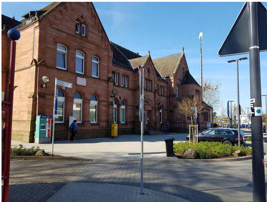
Abb. 8: Blick Richtung Südwesten auf Teilbereich 5, Empfangsgebäude (Foto BFU GmbH, 18.04.2018)
