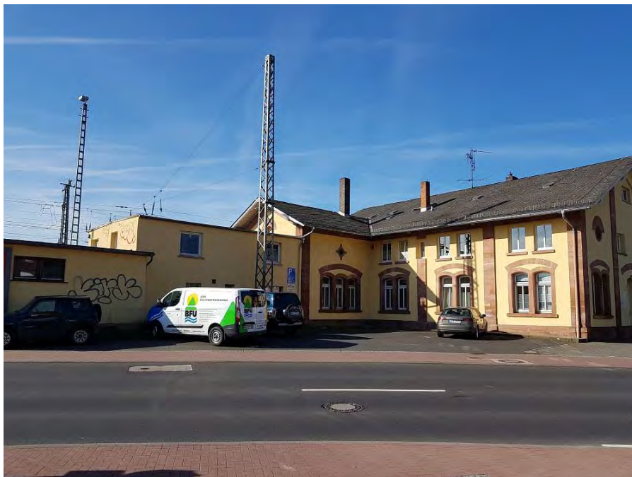
Abb. 12: Blick Richtung Südwesten auf Teilbereich 5, Gebäude Bahnmeisterei (Foto BFU GmbH, 18.04.2018)
