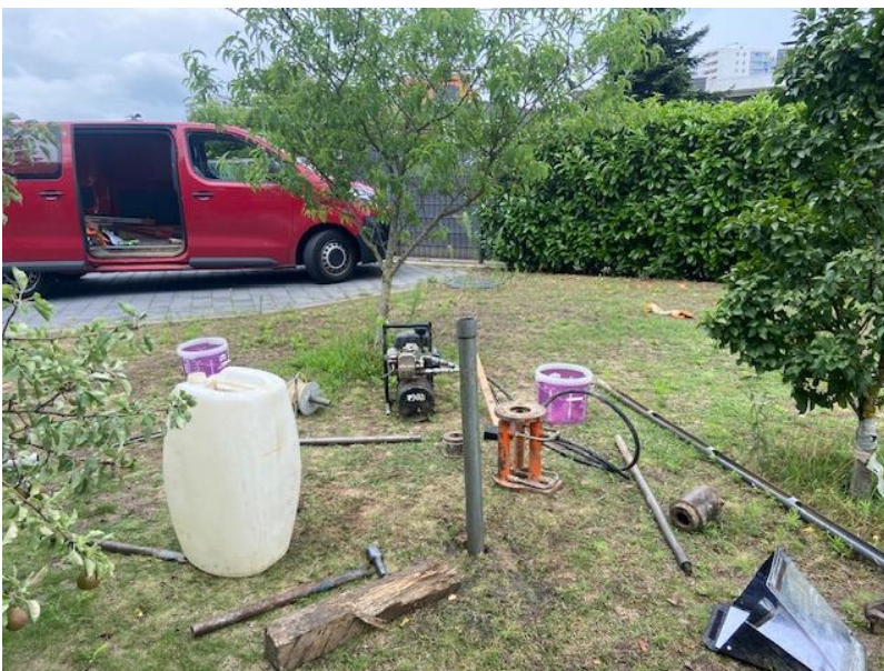
Foto 2: Blick auf Versickerungsversuch 2
