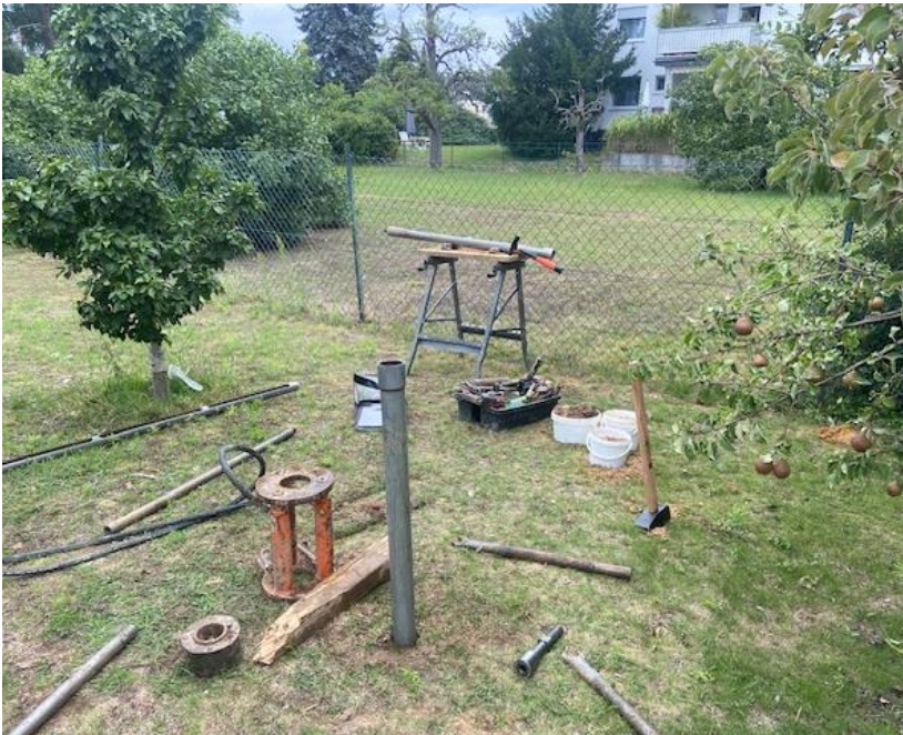
Foto 1: Blick auf Versickerungsversuch 1
