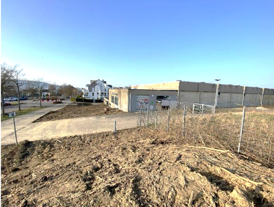
Foto 3: Bereits gerodete Gehölzbereiche entlang der Seelbacher Straße, Höhe Sporthalle
