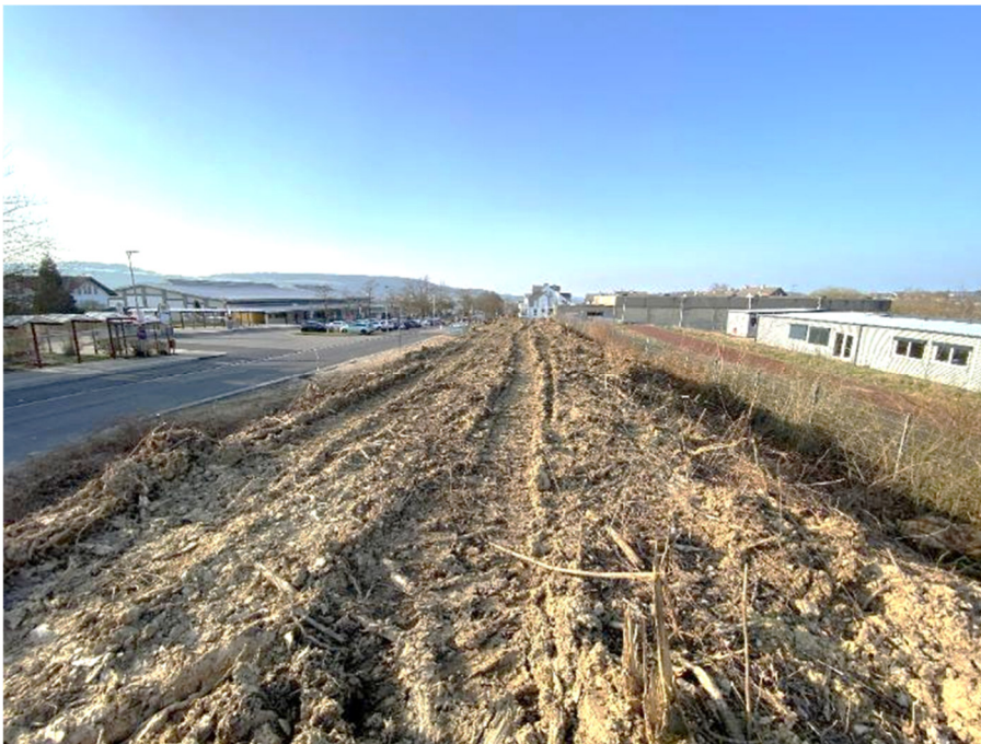
Foto 2: Bereits gerodeter Gehölzbereich entlang der Seelbacher Straße
