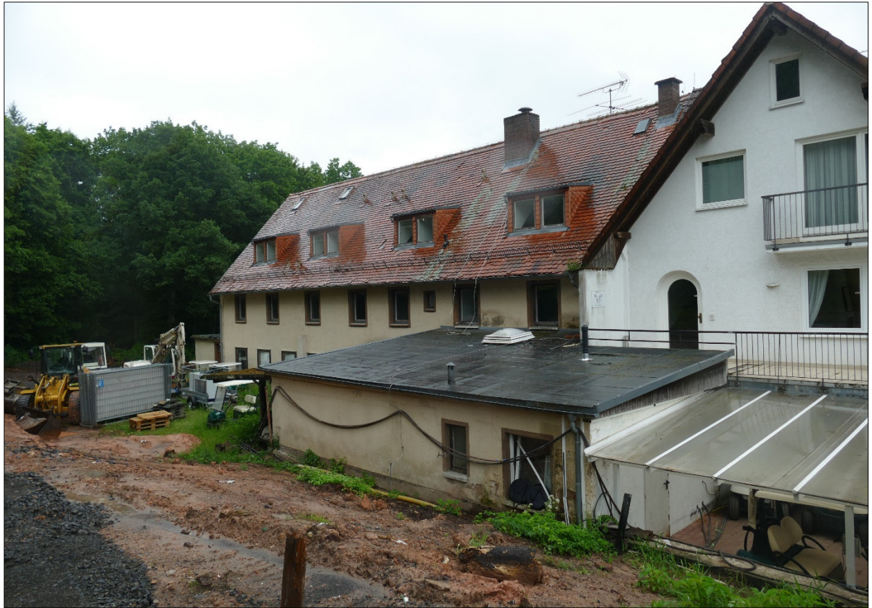
Abbildung 3: Verwaltungsgebäude (rechts im Bild) mit dahinter liegendem ehemaligem Hotel (links hinten im Bild) sowie Heizungs und Abstellschuppen mit Carport (Bildvordergrund) (Foto: IBU Juni 2025).
