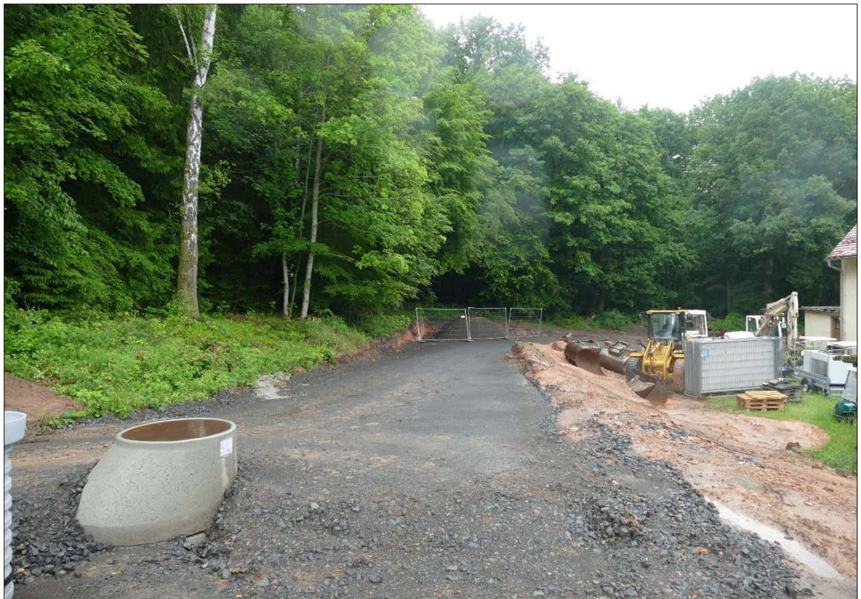
Abbildung 4: Geschotterte Baustellenzufahrt mit Böschung (rechts) und Mischwäldchen (links) (Foto: IBU Juni 2025).
