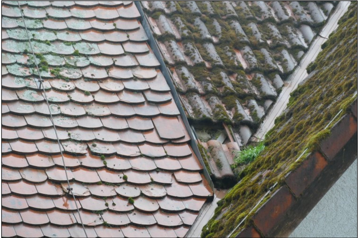
Abbildung 10: Spaltenzugang im Bereich des Dachs (Foto: IBU Juni 2025).
