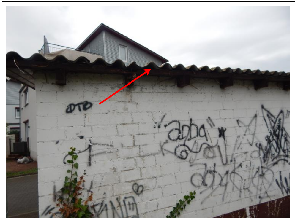
Abbildung 7: Schuppen mit potenziellen Quartierstrukturen
