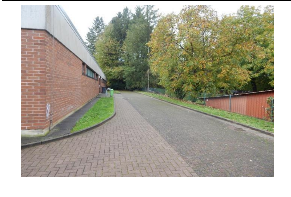
Abbildung 5: Bereich hinter der Trommhalle
