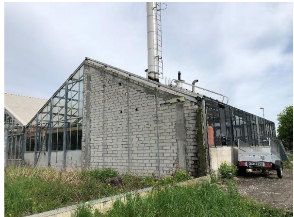
Abbildung 5: Gemauerter Teil der Fassade im Südosten
