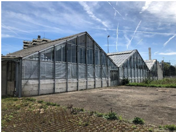
Abbildung 4: Südliche Fassade des Gewächshauses
