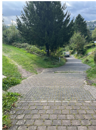
Gepflasterter Verkehrsweg im Hangbereich.
