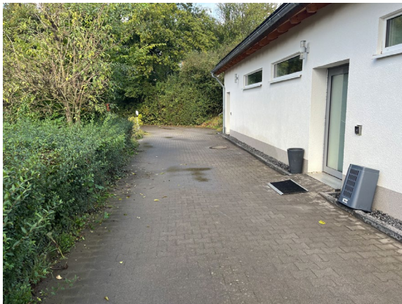
Pflaster vor dem nördlichen Sanitärgebäude
