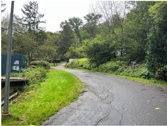
Asphaltierte Zufahrtsstraße, Niederschlagsversickerung an den Seiten.
