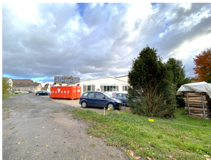
Foto 1: Asphaltierter Bereich Borngasse und geschotterte Weiterführung
