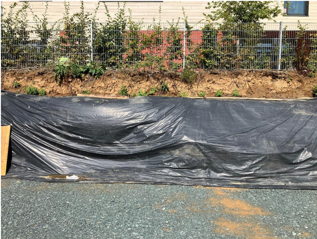
Abb. 4: Die abgedeckten Randbereiche der Baugrube im Südosten des Gebiets, 28.07.2024
