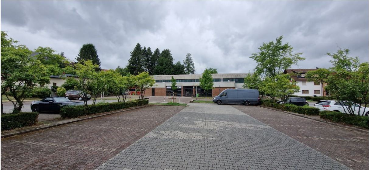
Abb. 8: Trommhalle und zugehöriger Parkplatz innerhalb des Plangebietes Quelle: Planergruppe ROB
