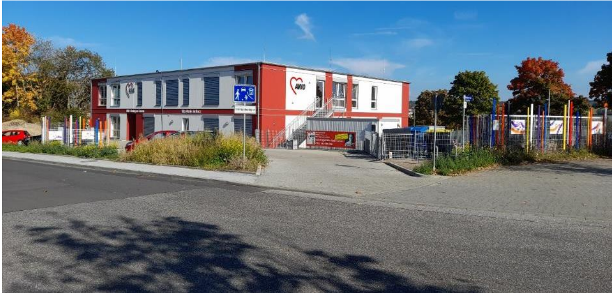
Abbildung 10: Nördlich angrenzende Kindertagesstätte „Marie Juchacz“ in Container-Bauweise - Quelle: Planergruppe ROB GmbH, Schwalbach am Taunus
