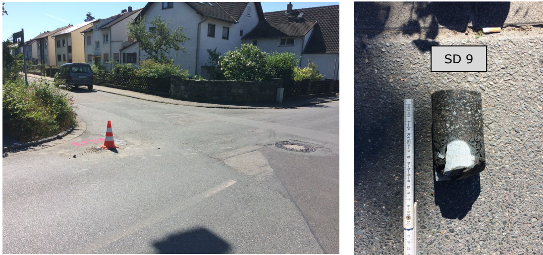
Abbildung 8 : Lage der Entnahmestelle und Bohrkern RKS 9/ SD 9
