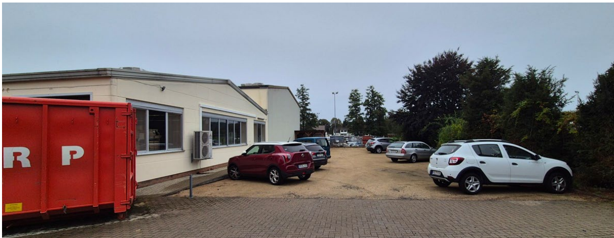
Abbildung 7: Rückwärtige Ansicht des Verpackungsherstellers Rosch Delta GmbH & Co. KG mit dazugehörigen Parkplatz Quelle: Planergruppe ROB GmbH
