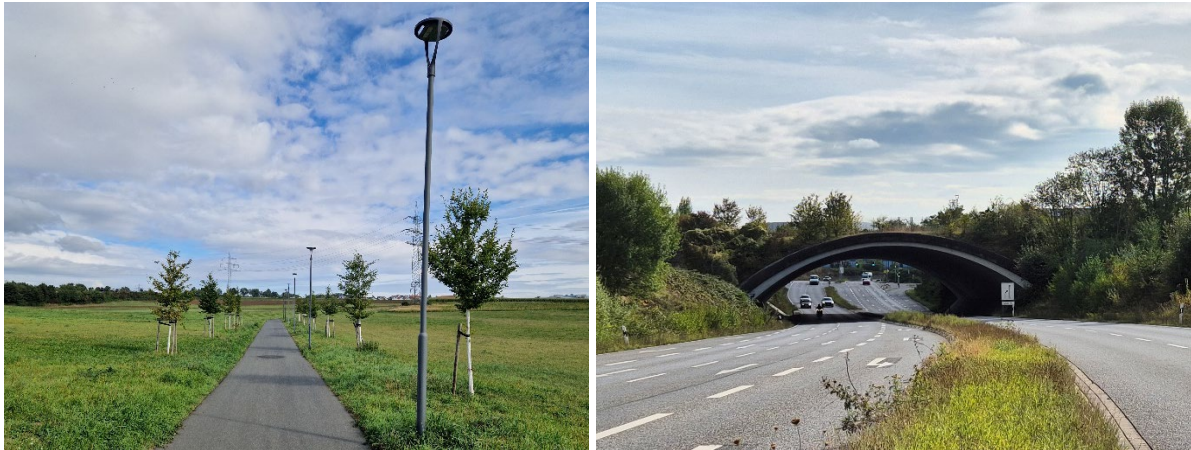
Abbildung 12: Bereits realisierte Fuß- und Radwegeverbindung innerhalb des zentralen Parks (links), bestehende Landschaftsbrücke (rechts) Quelle: Planergruppe ROB GmbH, Schwalbach am Taunus
