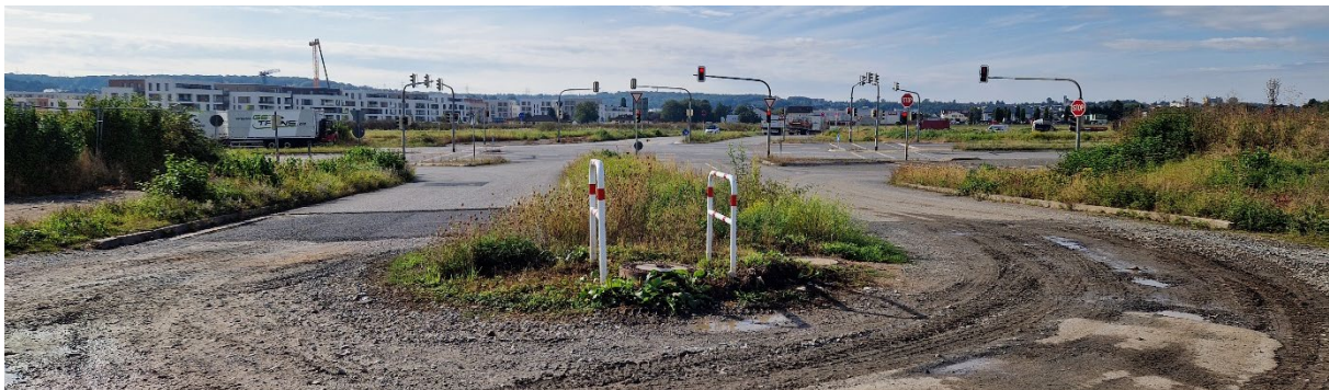
Abbildung 11: Bestehender Knotenpunkt innerhalb des Plangebietes zur Anbindung an die Nordumgehung (L 3008) Quelle: Planergruppe ROB GmbH, Schwalbach am Taunus
