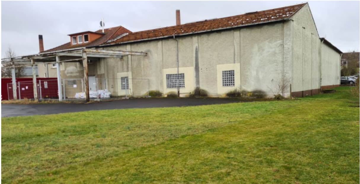
Abb. 23: Im Rückbau befindlicher Gebäudekomplex von Norden aus gesehen Quelle: Planungsbüro Vollhardt
