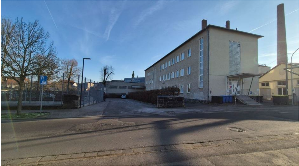
Abb. 13: Ehemaliges Betriebsgelände der Firma Robert Jackl GmbH & Co. KG Quelle: Planergruppe ROB
