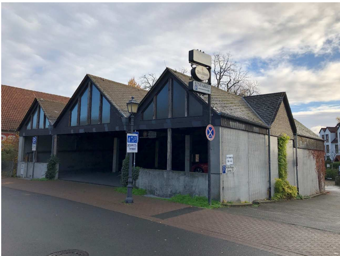
Abbildung 1: Das Parkhaus in der Sauererlenstraße in Schwalbach a. Ts., 19.11.2020
