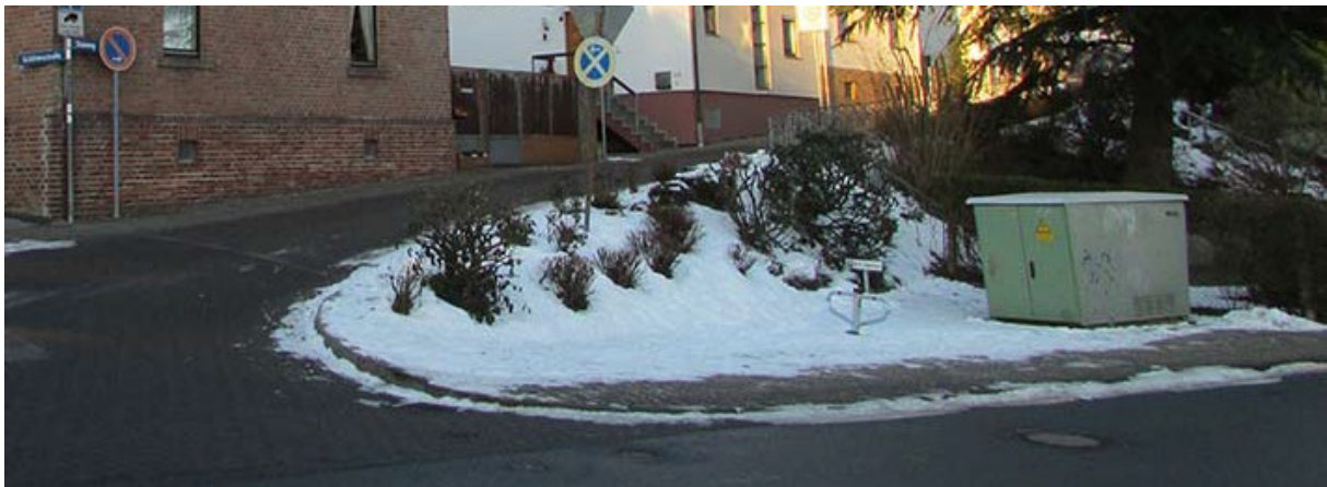
Abbildung 8: Trafostation innerhalb des Plangebietes
