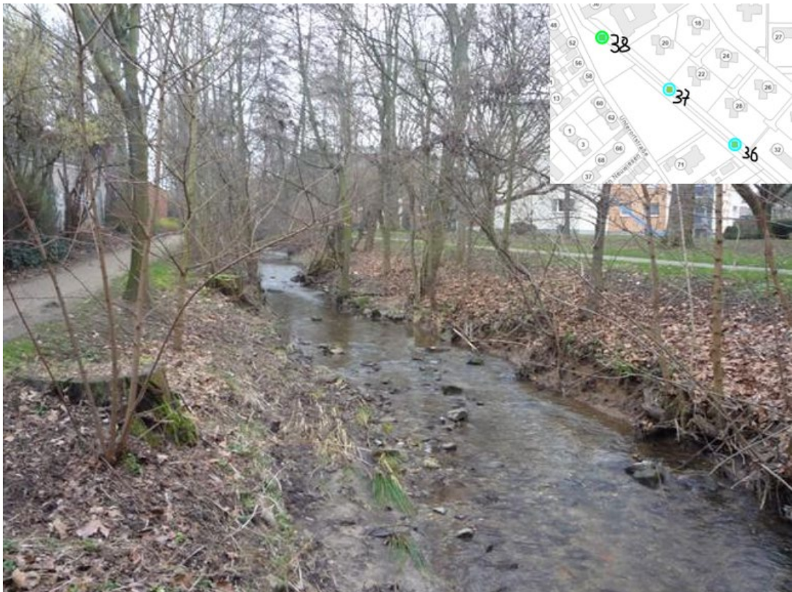
Abbildung 7: Fotostandort mit der ID 24896_37 am Westerbach, Quelle: [4]
