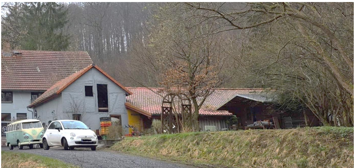
Abbildung 7: Nebengebäude im Süden des Plangebietes Quelle: Planergruppe ROB GmbH
