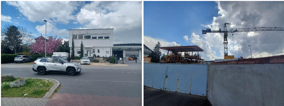
Abb. 15: Büro- und Wohngebäude (links) und rückwärtiger Bereich zur Rüdeshheimer Straße (rechts) der Bauunternehmung Hahn
