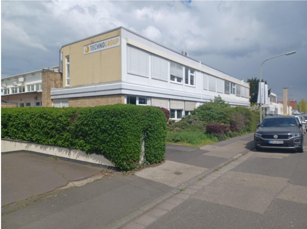
Abb. 11: Gelände der Firma Technogroup IT-Service GmbH im südlichen Bereich des Plangebietes
