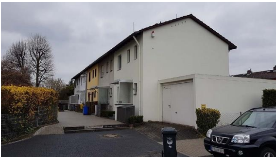
Abb. 8: Bebauung an der Sulzbacher Straße
