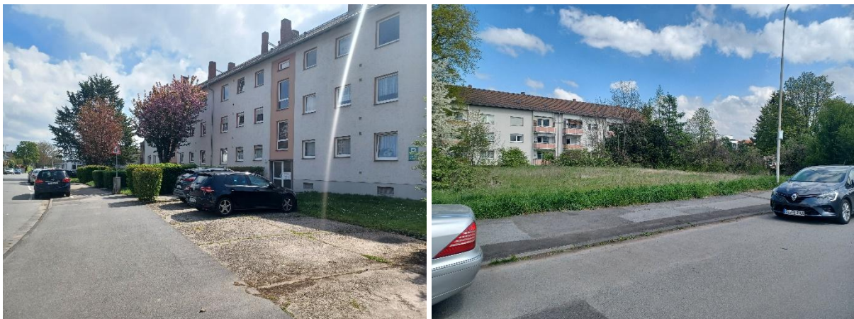
Abb. 13: Wohngebäude im Westen des Plangebietes mit dahinterliegender Grünfläche
