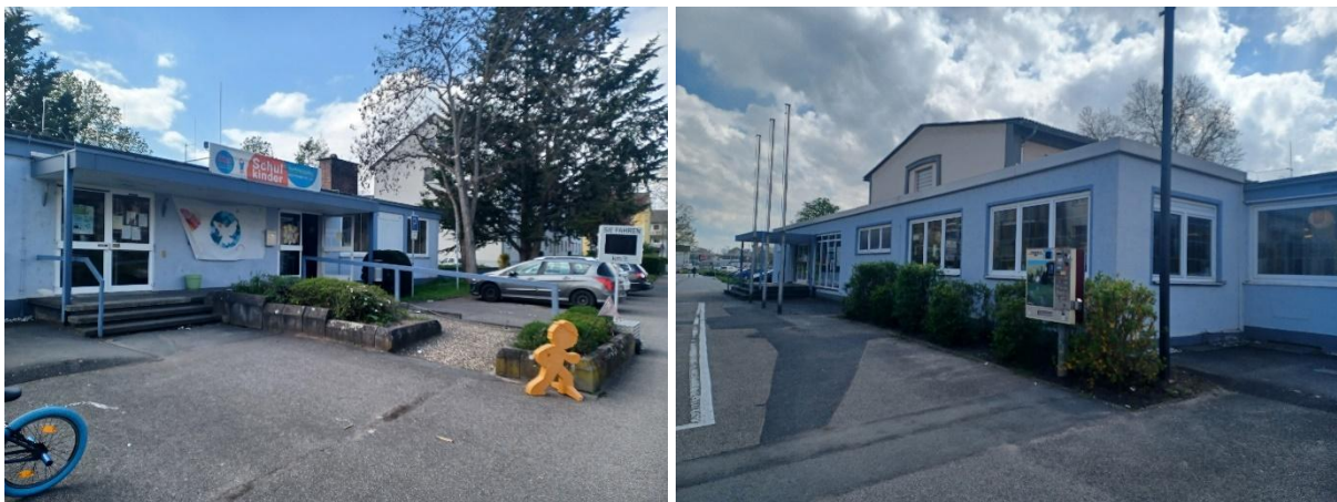
Abb. 12: Ehemaliges Bürgerhaus mit ehemaligem Schulkinderhaus
