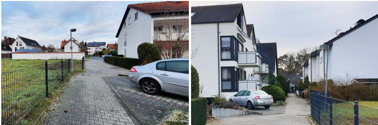
Abbildung 8: Verbindung zwischen Ahornweg und Eschenweg mit Blick auf den Ahornweg (links) und mit Blick auf den Eschenweg (rechts) Quelle: Planergruppe ROB GmbH
