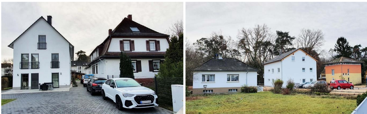
Abbildung 11: Bebauung entlang der Hohebergstraße Quelle: Planergruppe ROB GmbH
