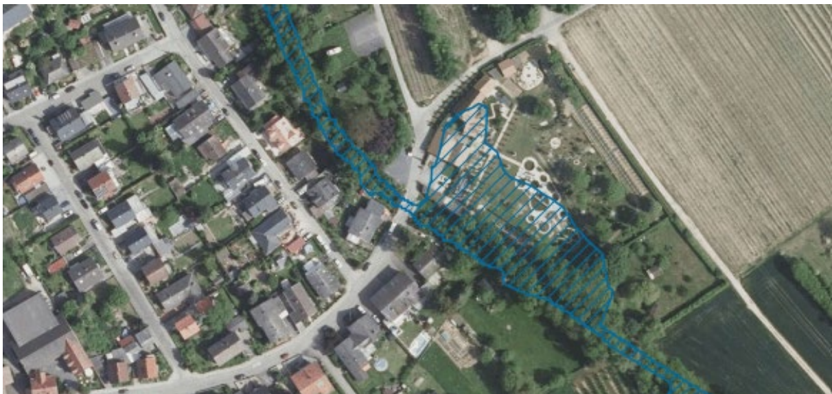
Abbildung 1: Gesetzlich festgesetztes Überschwemmungsgebiet innerhalb des Plangebietes Quelle: (MKUEM Rheinland-Pfalz)
