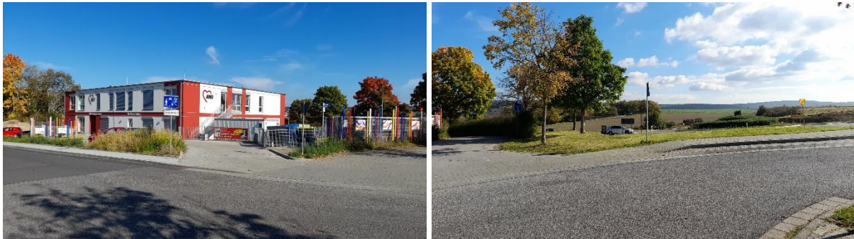
Abbildung 6: Südlicher Teilbereich: Container-Kita und Einmündung Seelbacher Straße in der südlichen Spitze des Plangebietes Quelle: Planergruppe ROB GmbH
