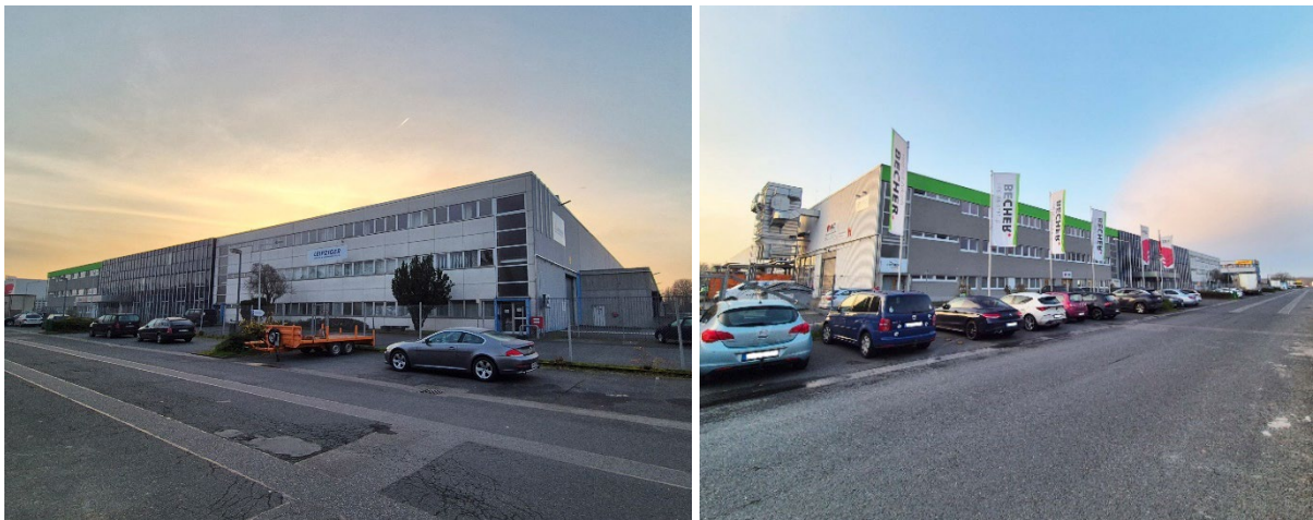
Abbildung 13: Bestehender Gewerbebetrieb für Lagerung und Logistik (links) und Logistikbetrieb für Holz (rechts) im östlichen Bereich des Plangebietes Quelle: Planergruppe ROB GmbH
