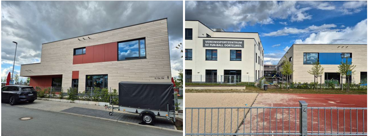
Abbildung 9: Kindertagesstätte (links) und Abstandsfläche zwischen den Gebäuden der Kindertagesstätten mit Familienzentrum und des Sportzentrums (rechts) Quelle: Planergruppe ROB GmbH, Schwalbach am Taunus
