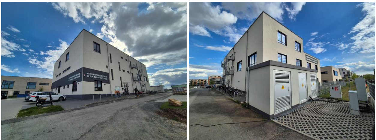
Abbildung 10: Gebäude des Sportzentrums (links) mit angrenzender Trafostation (rechts) Quelle: Planergruppe ROB GmbH, Schwalbach am Taunus
